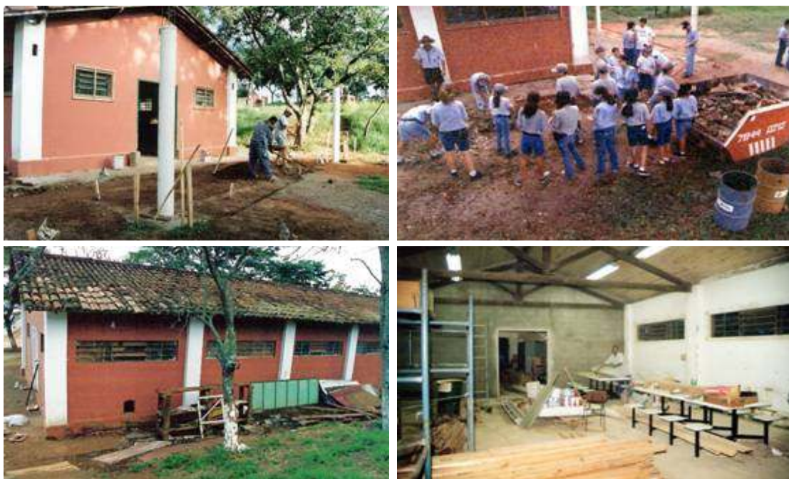
Figura 24 – Reforma da sede em 1999
