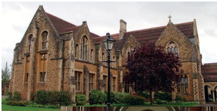
Parte externa da antiga capela.
